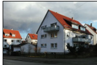
Stuttgart-Vaihingen und Rohr, zahlreiche ETW
